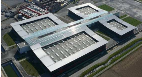
Vue aérienne de l'usine « Joseph Szydlowski » de Bordes
