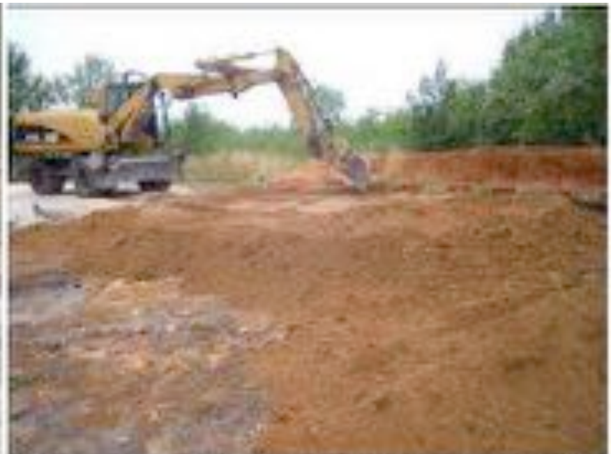
Figure 17 : Remblaiement et nivellement de la fouille avec de la terre végétale
